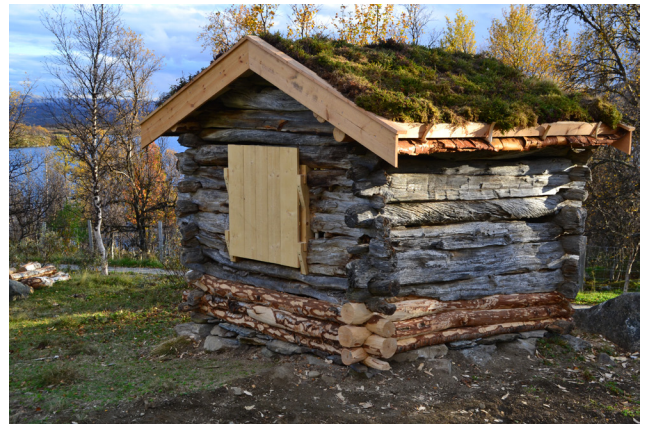
Nyrestaurert løe hos Anne Bjørnerås ved Djupsjøen. Foto: Karoline Finstad Vold
