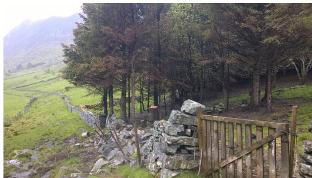
Røtene på dei høge sitkaganene utgjer eit trugsmål for steingardane i buråsa. Hogging av desse er ein del av det prioriterte skjøtselsarbeidet. Foto: Fylkesmannen i Sogn og Fjordane
