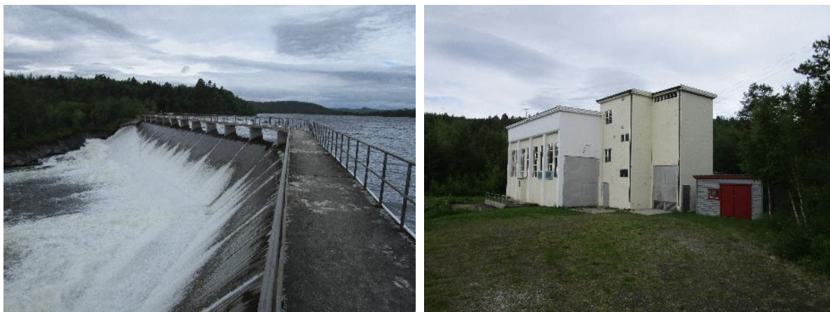
Figur 4-19: Av andre naturressurser utnyttes fallet fra Gakkajavri til kraftproduksjon. Innsjøen er demt opp, og det går en rørgate ned til kraftstasjonen
