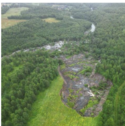
Figur 4 - Skredet ved Båtneset sist sommer
