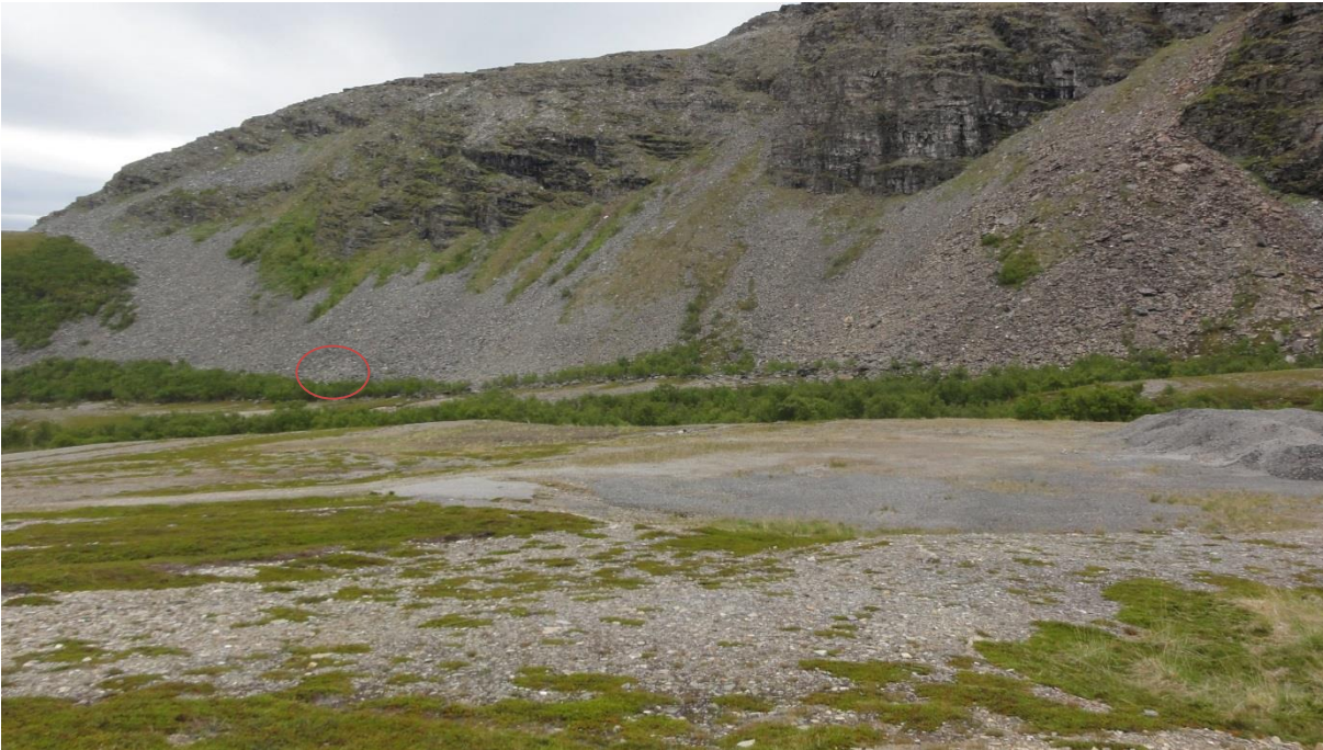
Skarvbergvika - rasutsatt urområde – Alt. 3 m/ tunnelpåhugg innringet
