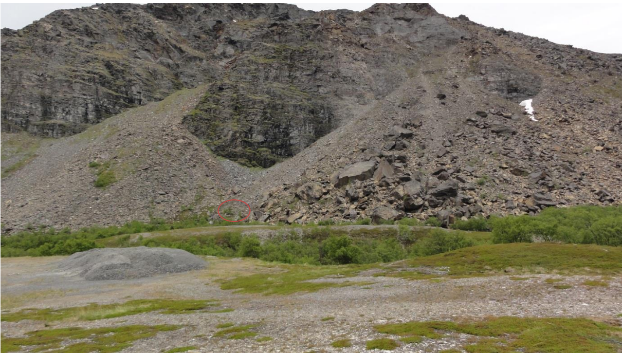
Skarvbergvika - rasutsatt urområde – Alt. 2 m/ tunnelpåhugg innringet.
