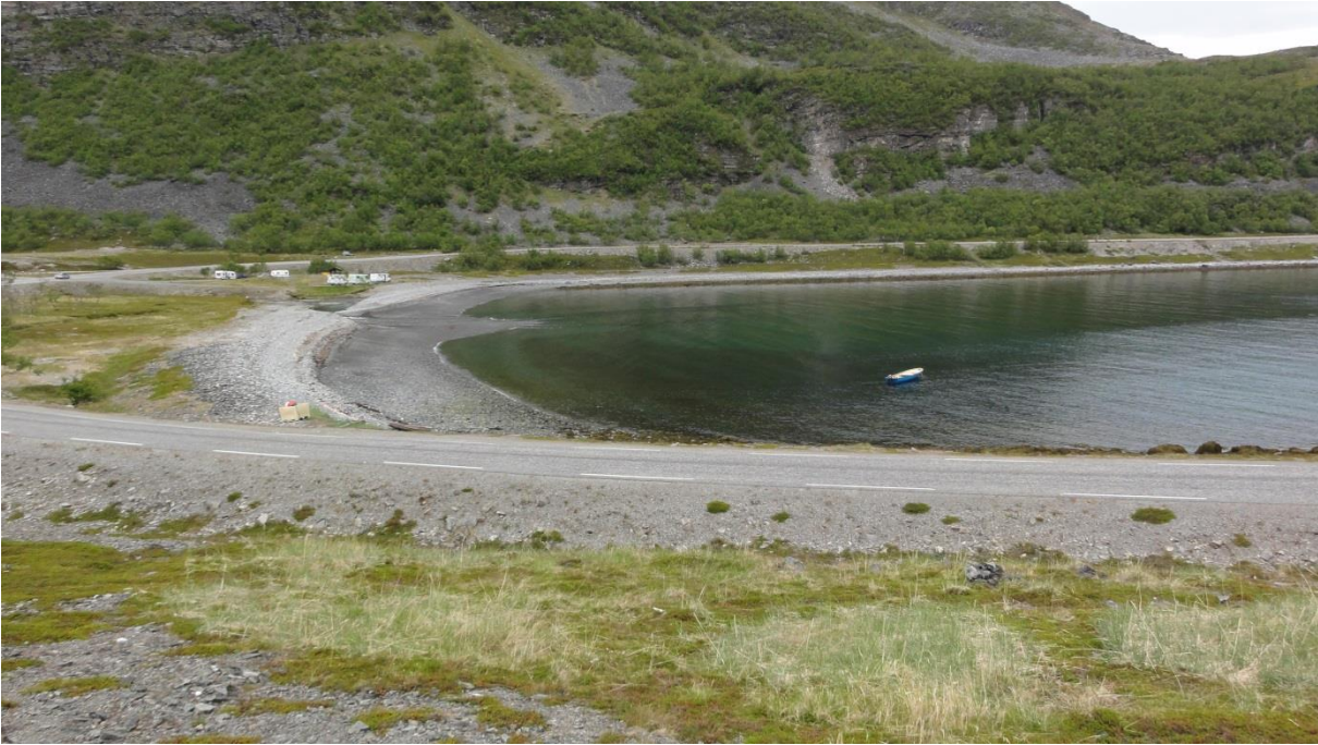
Skarvbergvika – område for sjøfylling, alt. 5. Dagens rasteplass i strandsonen skimtes i bakgrunnen
